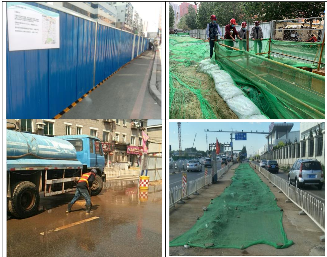
图 4.5-3 施工期苫盖、围挡污染防治措施
